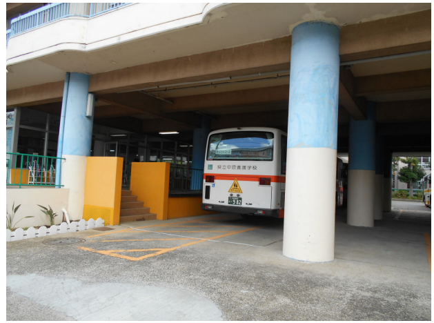
向の岡工のボランティアと作業したバス発着所
